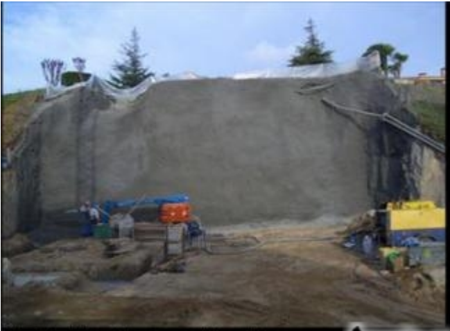
Aplicación de hormigón proyectado (gunita).
