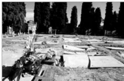
El cementerio de Campanar, poco antes de las obras. F. MONTAÑEGRO
